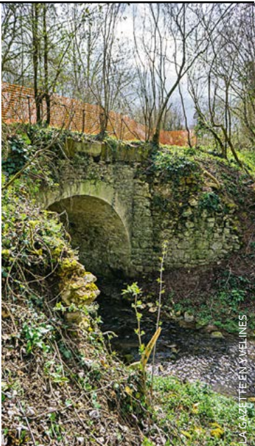
Loin de toute circulation depuis le XIX ème siècle, le pont Bât cheval était autrefois situé sur une route royale.
