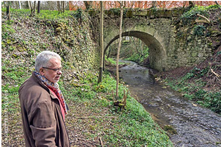
« Déjà, en 1650, ils avaient les mêmes problèmes », note de ce pont franchissant un ravin de huit mètres le maire Daniel Corbeau (SE).
