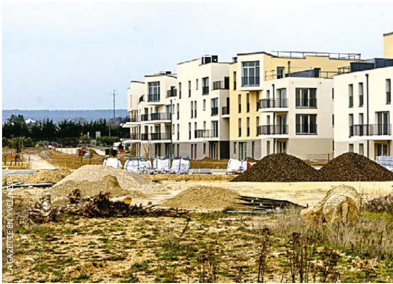
Les premiers habitants vont emménager dans l’un des 106 logements du bailleur social I3F, dont l’immeuble est le seul à être sorti de terre pour l’instant.
